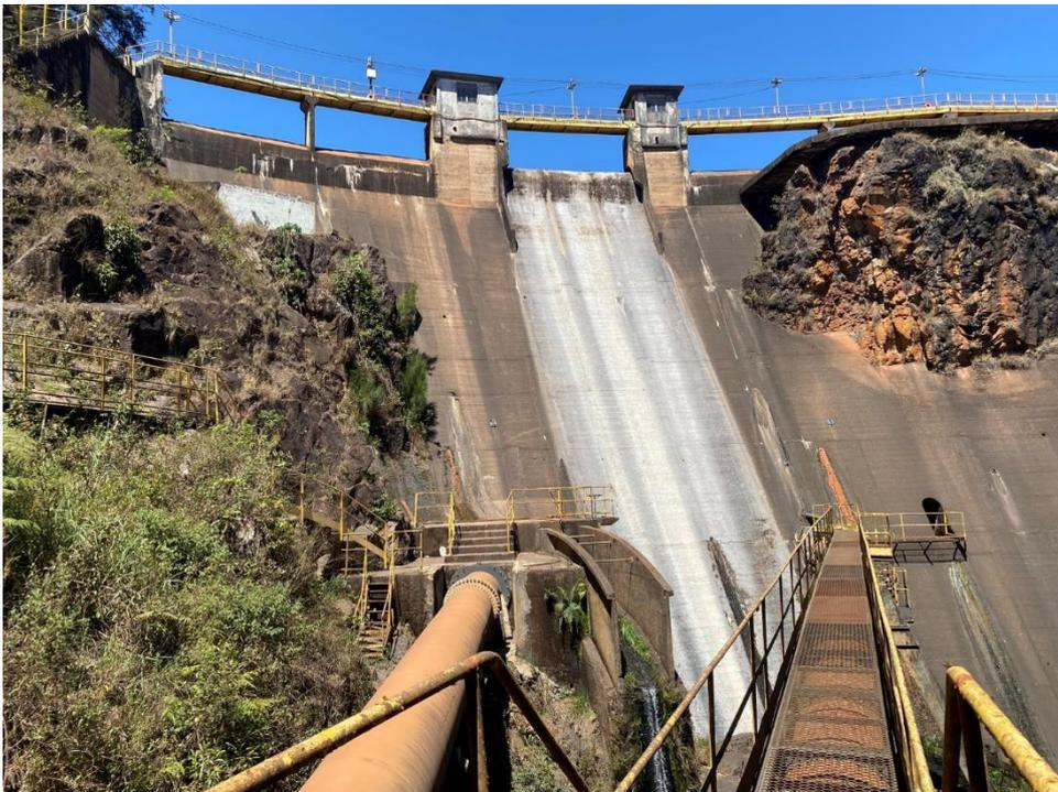
Figura 4.4 - Vista de jusante do sistema extravasor (soleira livre) da barragem Codorna.
