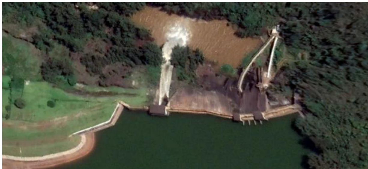
Figura 11: Barragem Codorna proprietário Anglogold, coordenadas: latitude -20.165555, longitude: -43.890152
