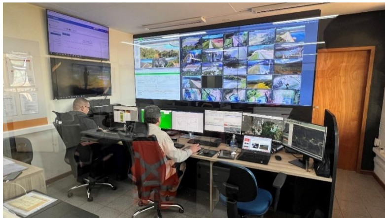
Figura 6: (CMG) Centro de Monitoramento Geotécnico de Barragens em operação.
