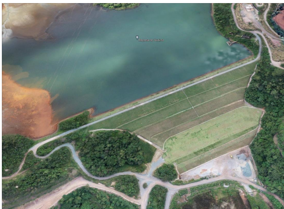
Figura 1: Vista aérea da Barragem Rapaunha
